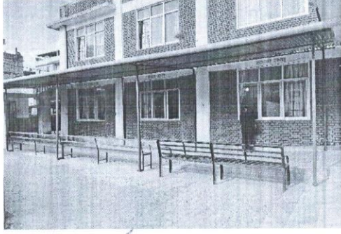
बागलुङ नगरपालिकाको सहयोगमा राहदानी शाखा, अभिलेख शाखा र नागरिकता प्रतिलिपि शाखामा टूस तथा फलामको कुर्ची निर्माण
